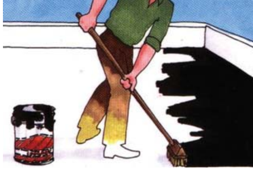
Şekil 6: Betonarme yüzeylerin bitüm ile astarlanması.
