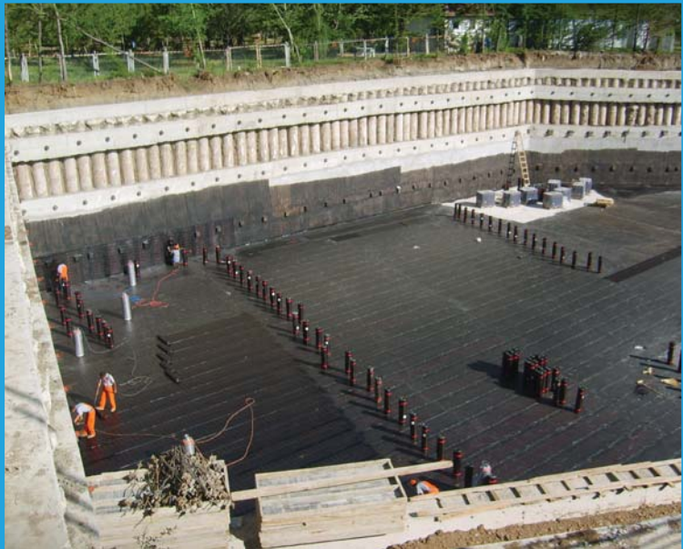
Detay 2- Basıncsız su ve neme karşı temel yalıtımı detayı
