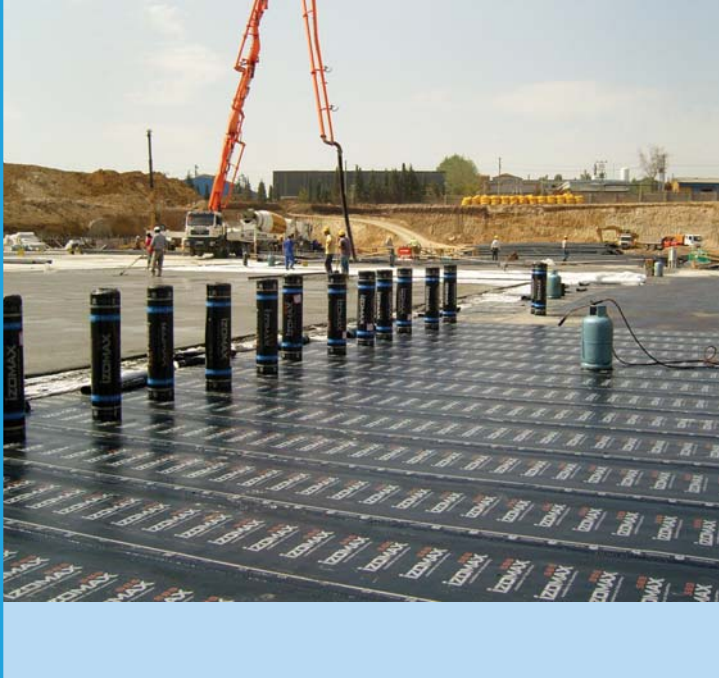
Detay 1- Basıncılı suya karşı temel yalıtımı (dıştan bohçalama) detayı
